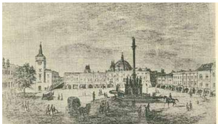
Kroměřížský Hrubý rynek byl v roce 1848 kol dokola obklopen podloubími. Ve středu pod západním podloubím se rýsuje střecha Kovářské brány, která byla zbudována v roce 1857. Do radnice se vcházelo schodištěm zvenčí, kasárny (nyní hotel Simon) byly ozdobeny třemi věžičkami.
